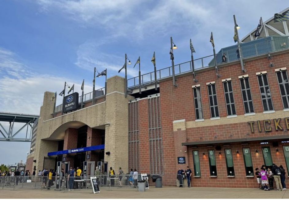
Fig. 22: Exterior of Subaru Park
